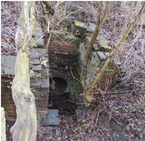
Abbildung 27: Ehemaliges Auslaufbauwerk Rieselfelder (Quelle: Stadt Datteln)
